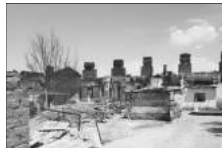
Сгоревшие после взрывов боеприпасов здания в Арыси. Туркестанская область, 28 июня 2019 года.
